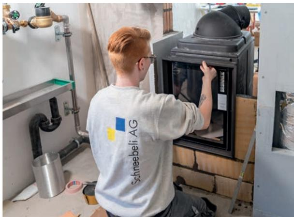
◀ **Pose d'équipements préfabriqués** L'installation de foyers préfabriqués industriellement fait aussi partie des activités des poêliers-fumistes et poêliers-fumistes.
