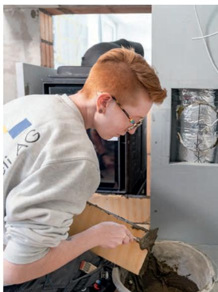
◀ **Crépiçage et maçonnerie** Les poêliers-fumistes et poêliers-fumistes peuvent crépiçer les cheminées ou les poêles et exécuter des travaux de maçonnerie (construction de socles, par exemple).
